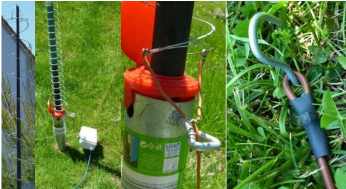
Figure 8 : Détails de l'antenne du sommet à la base.
